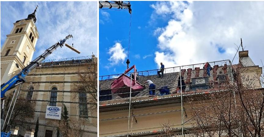
Die fleißigen Dachdecker haben bereits einen größeren Teil der Ostseite und auch der Westseite unserer Kirche neu gedeckt. Täglich werden die alten Dachlatten abmontiert und durch neue ersetzt. Dasselbe geschieht mit den Ziegeln. Für die Finanzierung des Daches werden von der Pfarre noch ca. € 50.000,- aufzubringen sein.
